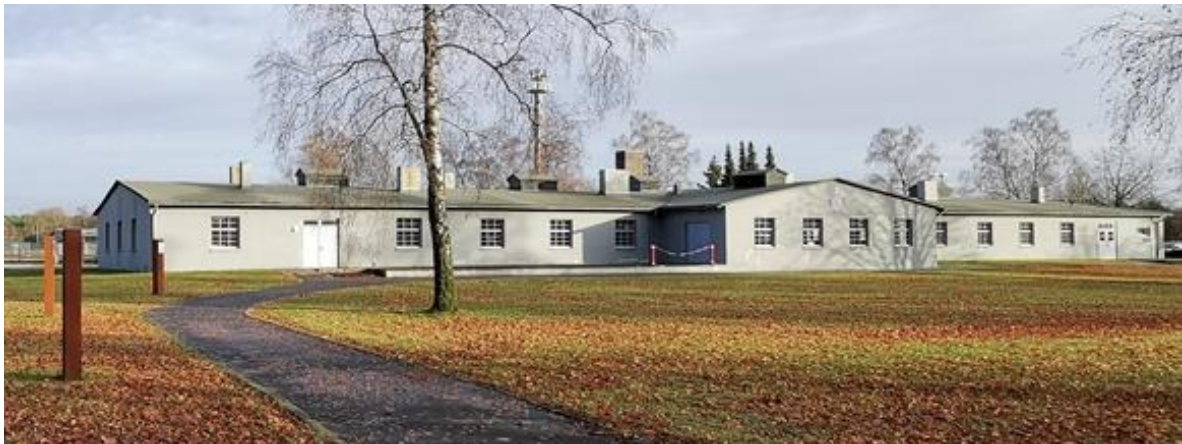
Heutiger Erhaltungszustand des Entlausungsgebäudes auf dem Gelände des LAFP (O. Nickel)
